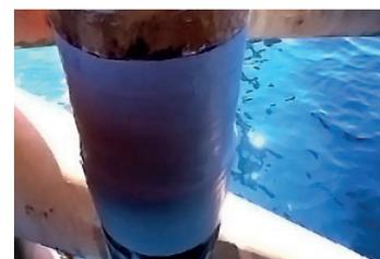
Герметизация места соединения стальной и неопреновой облицовки райзера на уровне ватерлинии
