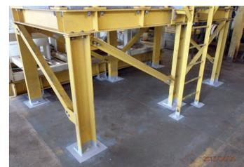
Защита болтового крепления опор платформы
