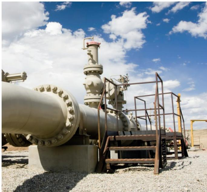
Belzona 3411 — не содержащее растворителей гибридное полимерное покрытие, применяемое для полной инкапсуляции элементов сложной формы, таких как фланцы.
