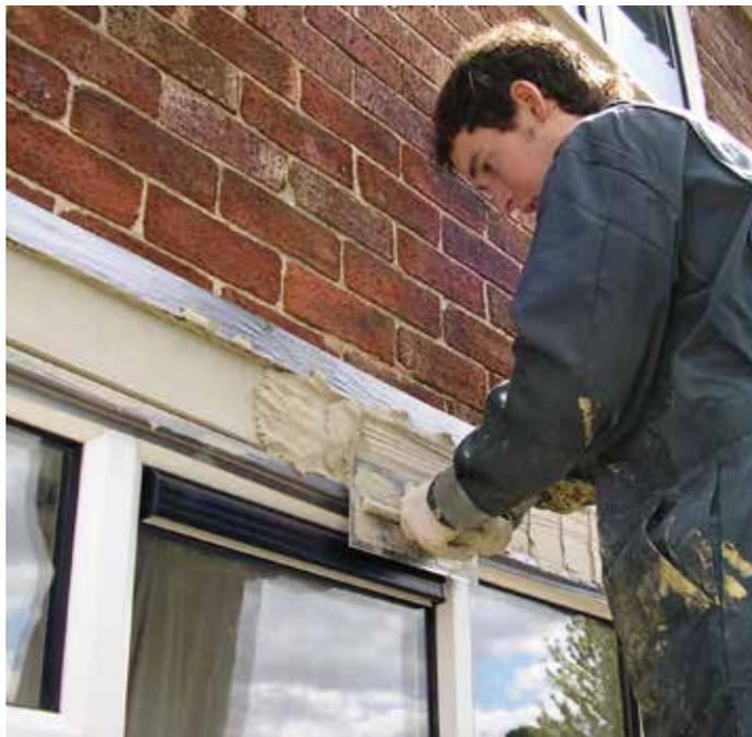
Belzona 4141 (Magma-Build) — двухкомпонентный легкий ремонтный композит для восстановления поврежденных вертикальных и потолочных бетонных поверхностей. Материал пригоден для нанесения толстым слоем, что существенно упрощает проведение ремонта, при этом он обеспечивает долгосрочную защиту поверхностей.
